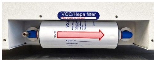
12.3 pav. Tinkamai įdėtas LOJ ir HEPA filtras
